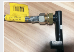
步骤3: 将柔性软管与 单向转接头连接
